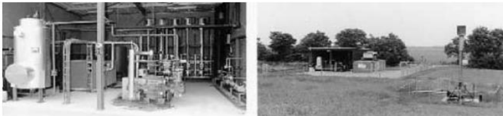
음식물찌꺼기 쓰레기 매립지에 설치된 UBE탄산가스 분리장치에
