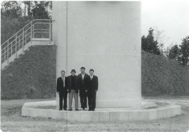
交流ボランティアと豊北風力発電所を見学しました。
