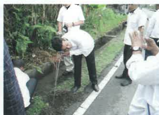
音聴棒による漏水確認技術を指導しました。
