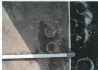
沈澱池で塩素を注入していますが、不純物が多く塩素が消費され残塩反応がありません。
