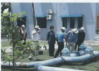
PDAMの浄水場現場を確認しました。
