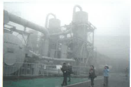
九州電力(株)八丁原地熱発電所で地熱発電施設を見学しました。
