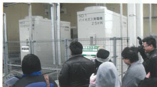
おおき循環センターで生ごみからメタンガスの発生設備を見学しました。
