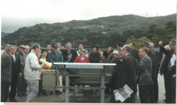
J-POWERの太陽光発電所(1MW)
