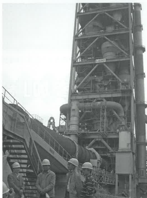
宇部興産(株)宇部セメント工場でセメントキルンによる資源リサイクル設備を見学しました。
